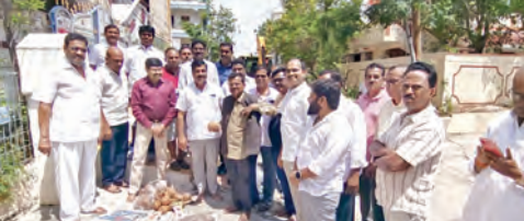
ఎస్.సి.ఐ. కాలనీలో సి.సి.రోడ్డు పనులకు శంకుస్థాపన చేస్తున్న కార్పొరేటర్ రాగుల.
